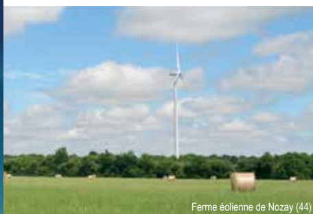
Ferme éolienne de Nozay (44)
